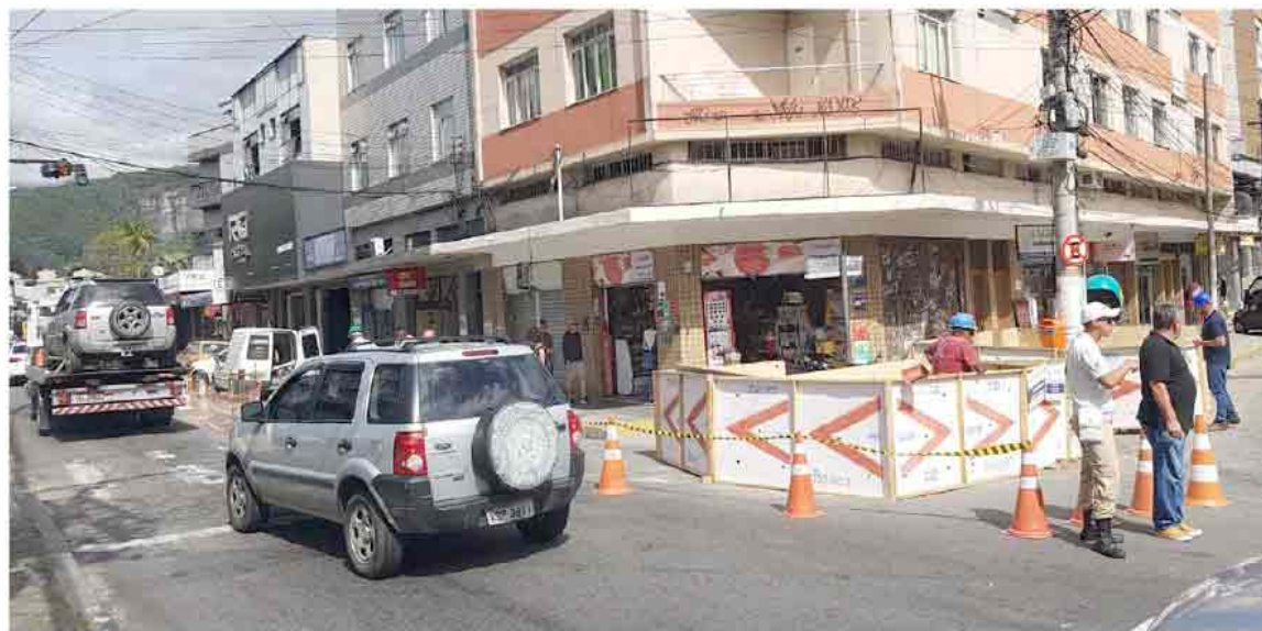
As obras, próximo à rotatória do Paissandu, deixaram a Avenida Julius Arp em meia pista, o que contribuiu para as retenções
