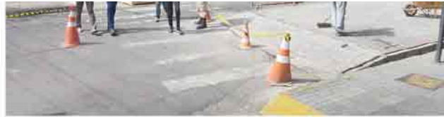
Na Avenida Julius Arp está sendo instalada uma faixa elevada para pedestres
